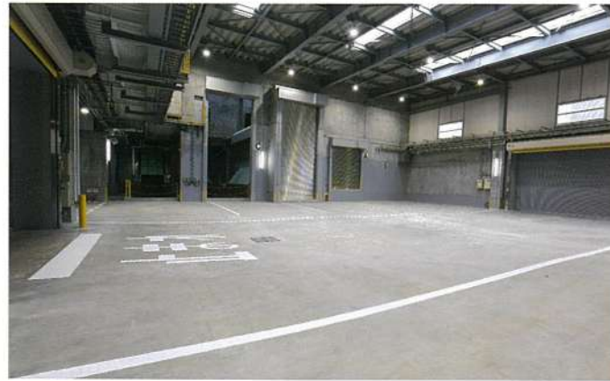
プラットホーム 搬入されたごみをここから不燃ごみピットへ投入します。
