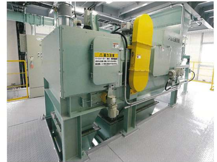
アルミ選別機 破砕物からアルミ類を選別します。
