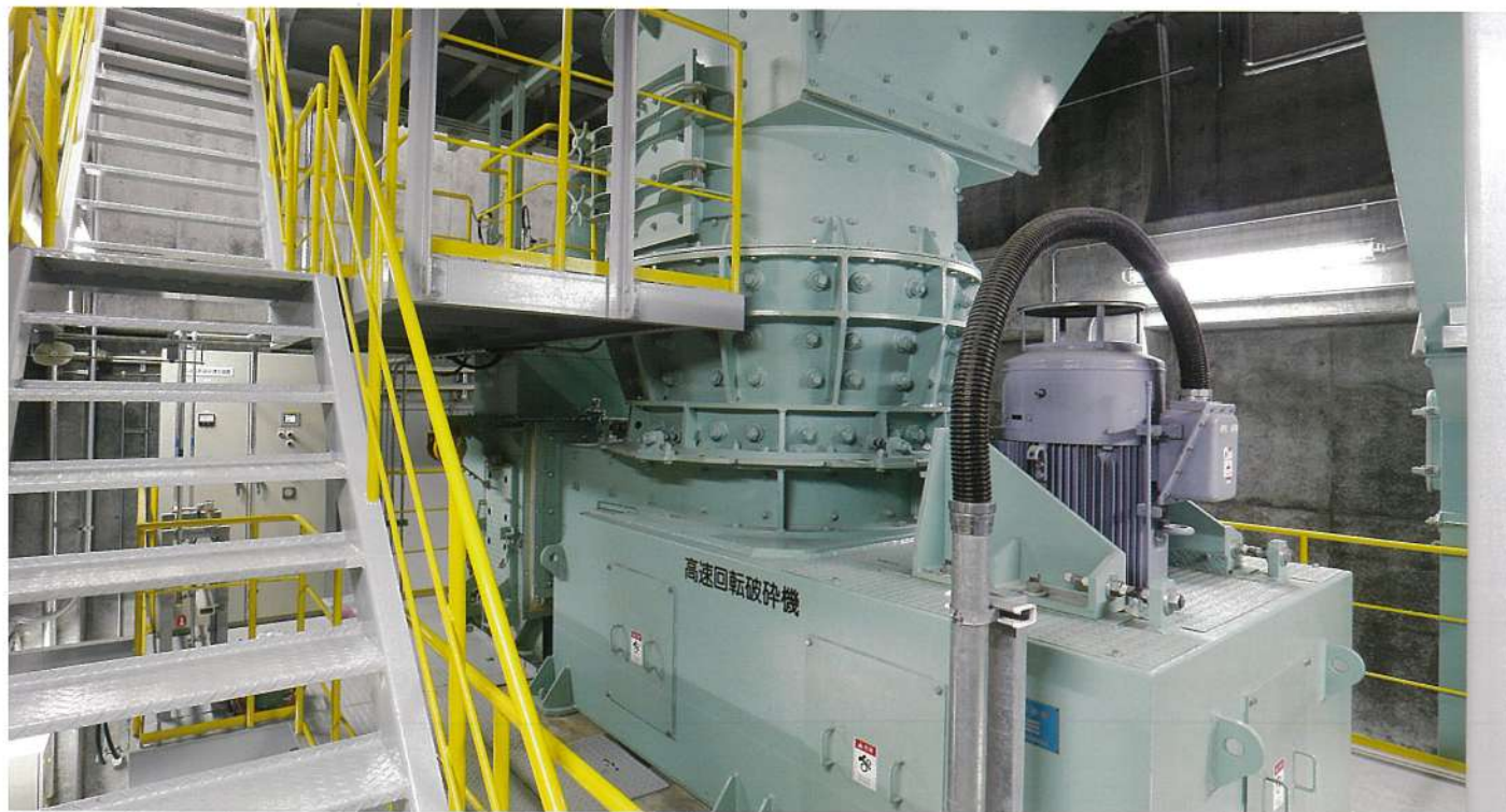
高速回転破砕機 高速回転するブレードとグラインダーで、せん断・衝撃・圧縮・引裂・摩耗等の破砕力がいろいろと組合わさり、不燃ごみ・不燃性粗大ごみを細かくします。
