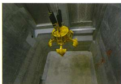
1 不燃ごみピット
