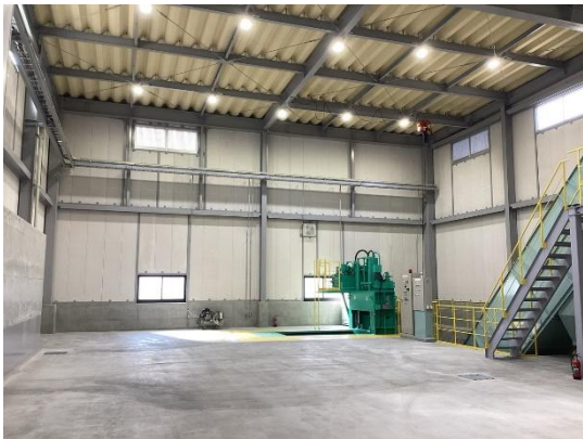
受入れヤード
