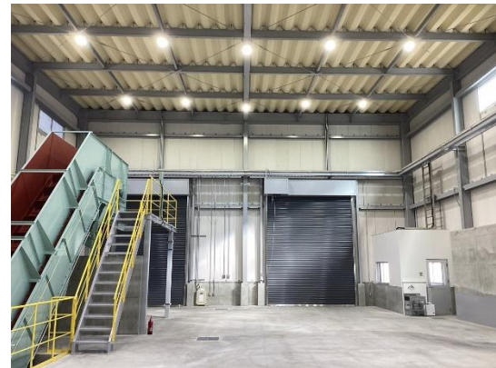
受入れヤード
